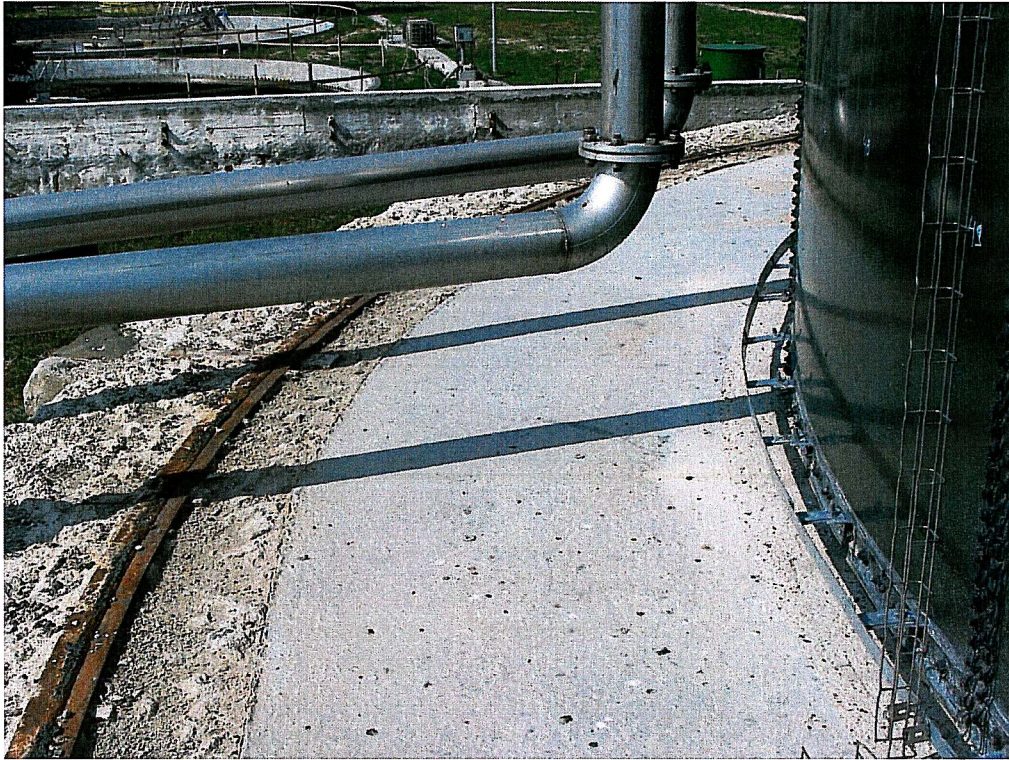
Foto.1 Widok fragmentu zbiornika (płaszcz stalowy, styk starego i nowego fundamentu)
